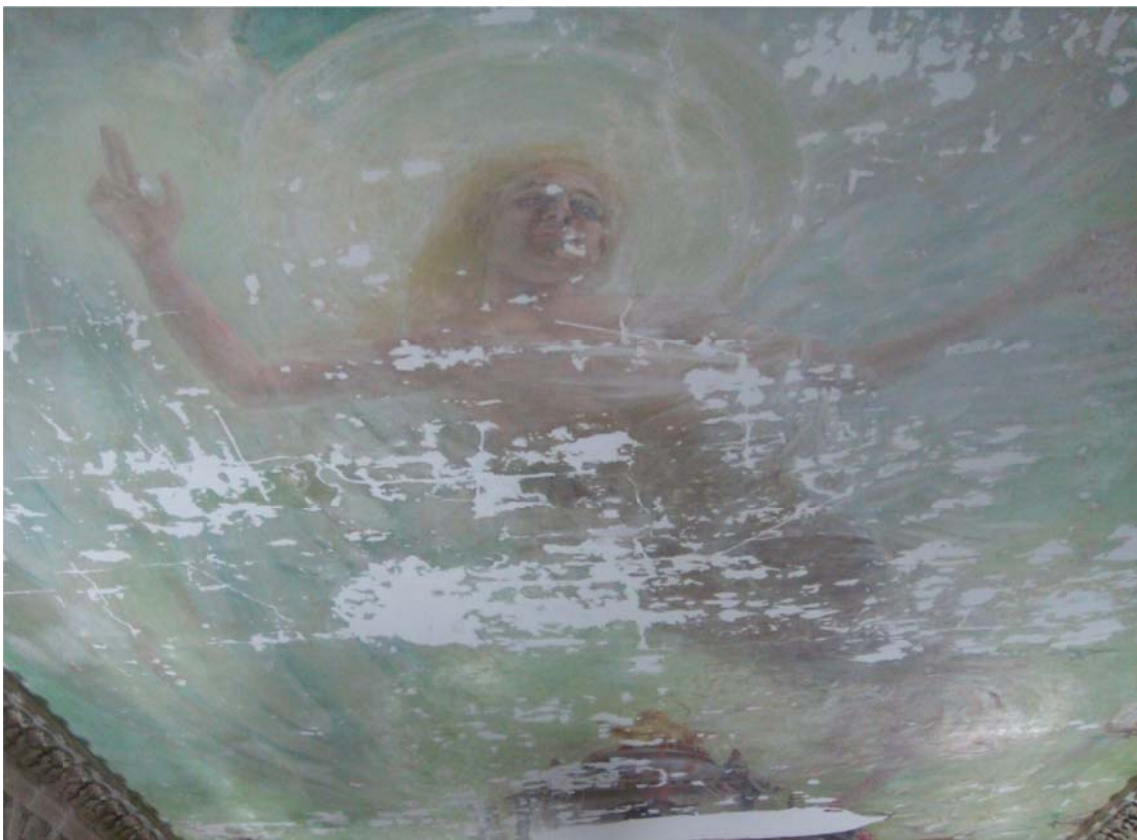
Fig. 12 - Vista parcial após nivelamento e aplicação de verniz de isolamento
