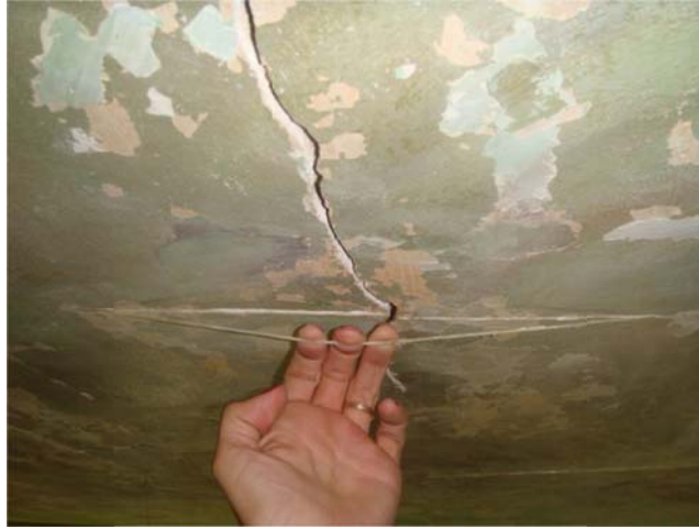
Fig. 11 - Teste para remoção dos fios de nylon
