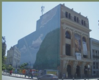
Vista das fachadas principal e lateral.
