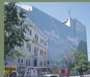
Vista da fachada lateral com pintura de Ivan de Freitas.
