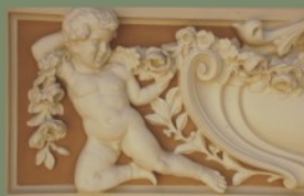
Detalhe de painel figurativo da fachada principal com a pintura finalizada.
