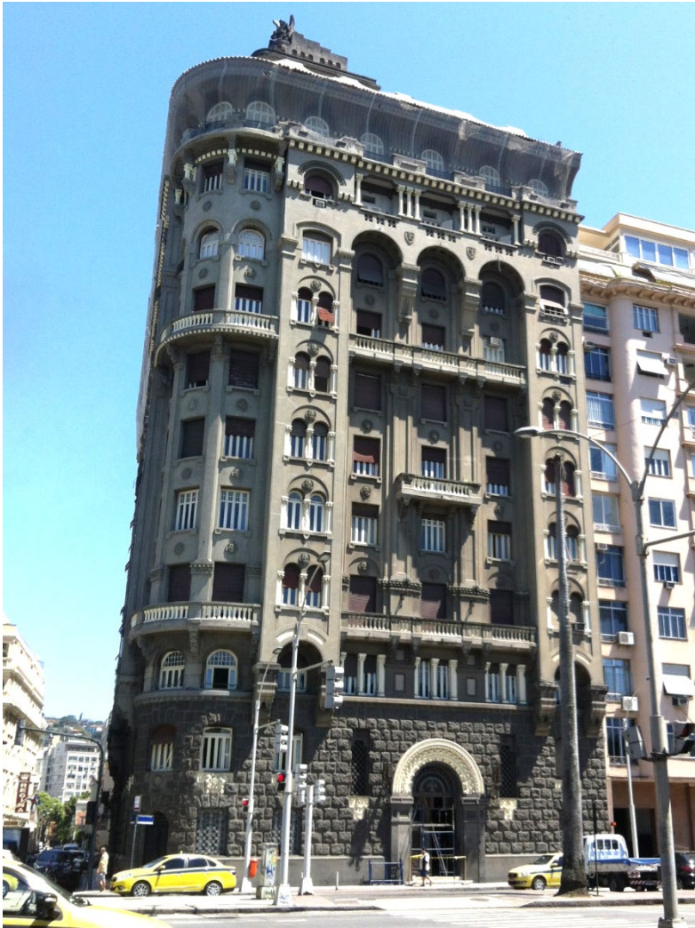
Restauração da fachada da Praia do Flamengo em revestimento de pó-de-pedra
