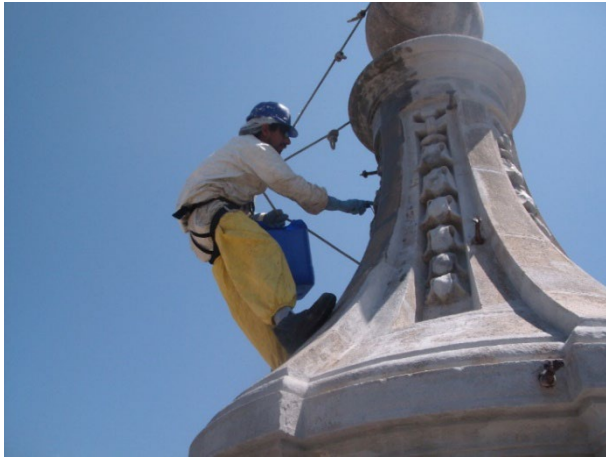
Impermeabilização da cúpula e restauro da estucaria ornamental
