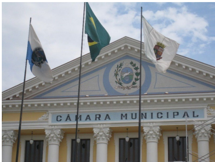
Restauração da fachada principal
