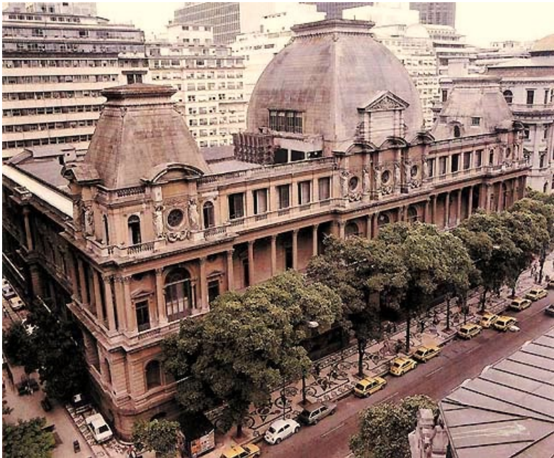
Restauração do telhado e de pisos internos
