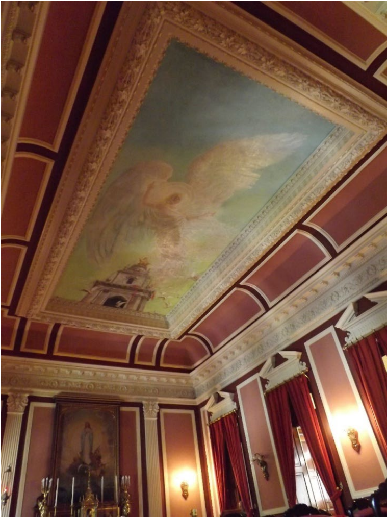
Restauro de pintura sobre tela de teto de Carlos Oswald, de pinturas decorativas e de estuques com douramento nas paredes
