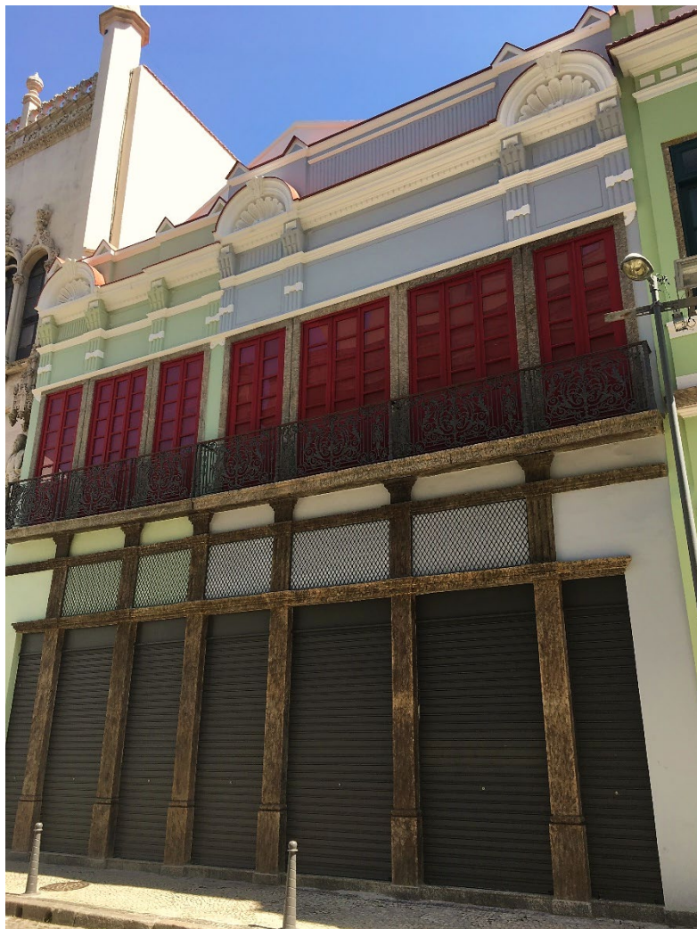
Restauro da fachada e reforma interna para novo uso
