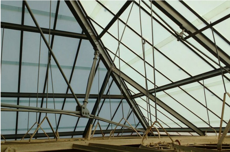
Vista interna da claraboia principal
