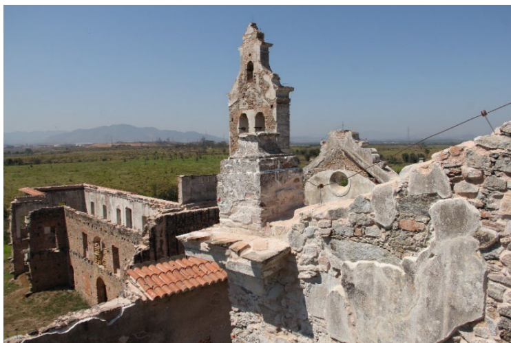
Consolidação das superfícies argamassadas e topo das alvenarias
